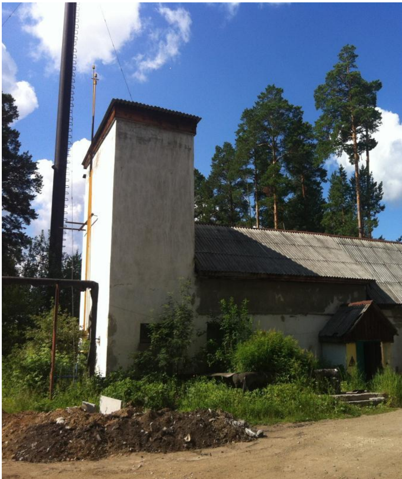
Газовая котельная п. Верхняя Сысерть.
