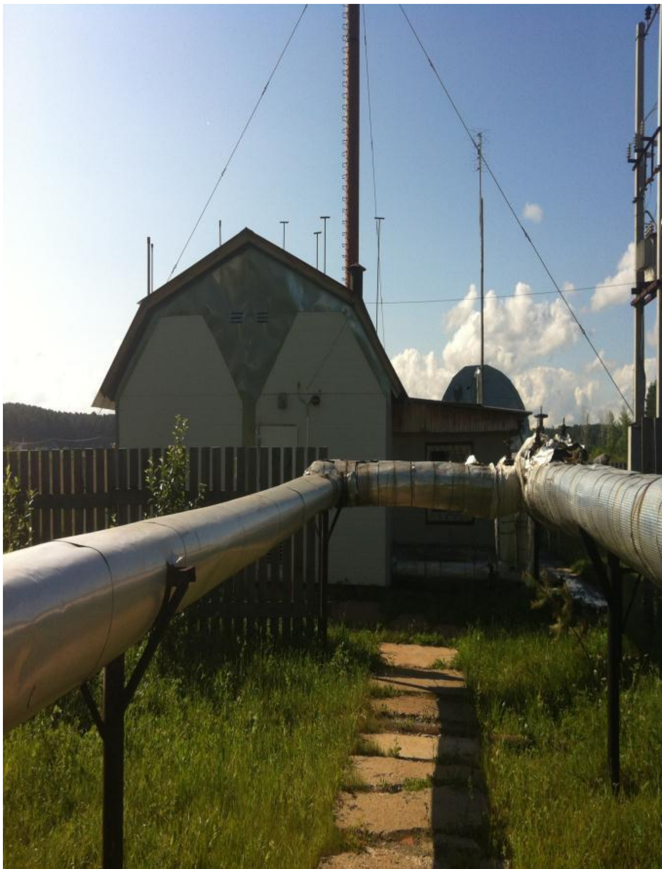
Газовая котельная с. Кашино.
